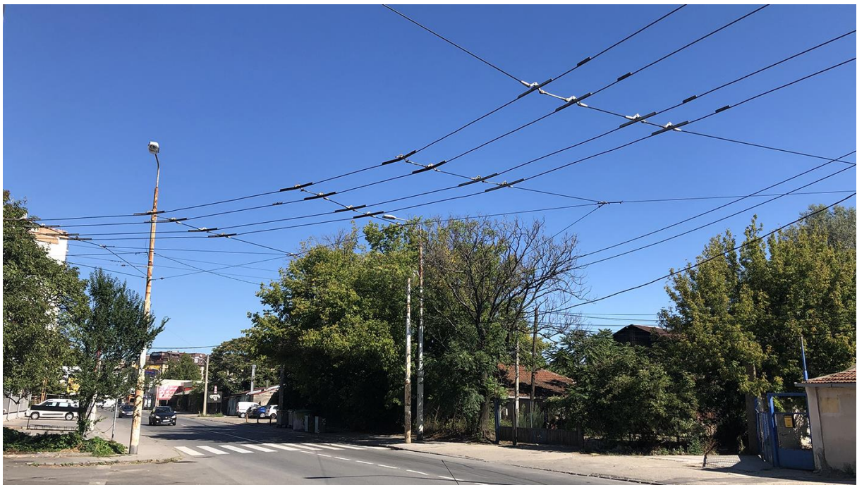
Постојеће стање Форографија локација - тачка 4 , фото Д.М
